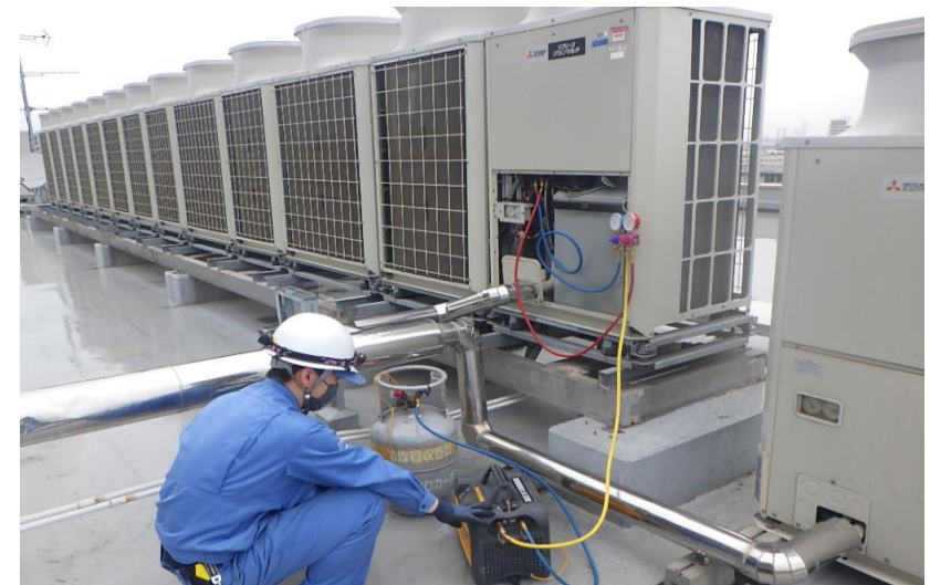
冷媒回収作業
